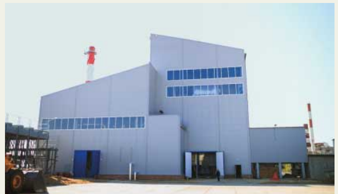
Новая теплостанция в г. Сыктывкаре (Республика Коми), в год потребляющая 83 200 т топливной щепы (коры) и производящая 4,3 МВт энергии
