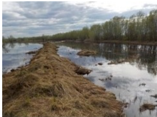
До: Земляной вал, преградивший дальнейшее распространение нефтесодержащей жидкости.
