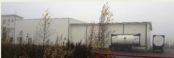
Производственные помещения компании Nordic Koivu в поселке Тохмаярви (Северная Карелия)
